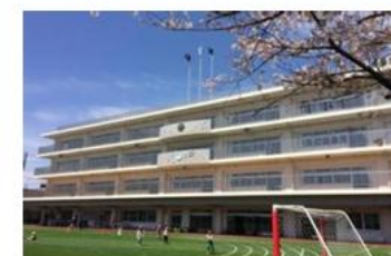
▲鹿浜五色桜小学校外観
