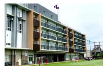
▲南向きにある普通教室とグラウンド
