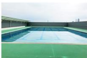
▲プールは屋上に配置されている。
