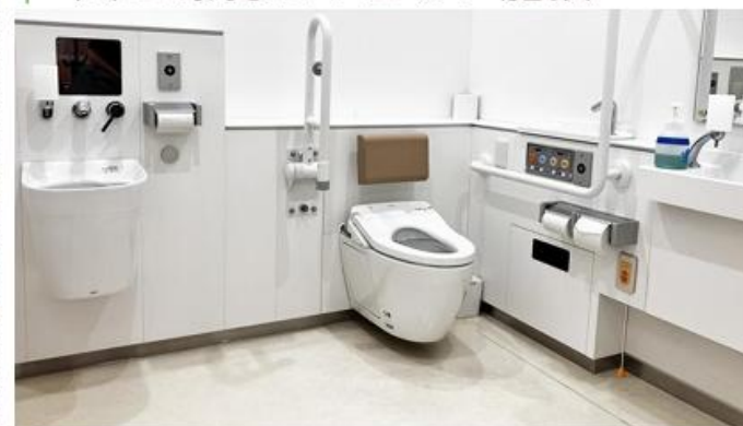
▲多機能トイレにはオストメイト対応設備や可動式手すり等が設置されている。
